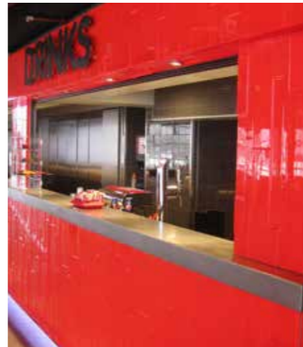
Kool - Ahoy Rotterdam - 2K epoxy coating
